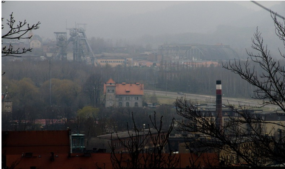
Wałbrzych z lotu ptaka, widok na Starą Kopalnię, która obecnie jest rewitalizowana i zamieniana w centrum turystyczne, tzw. „park wielokulturowy”.
